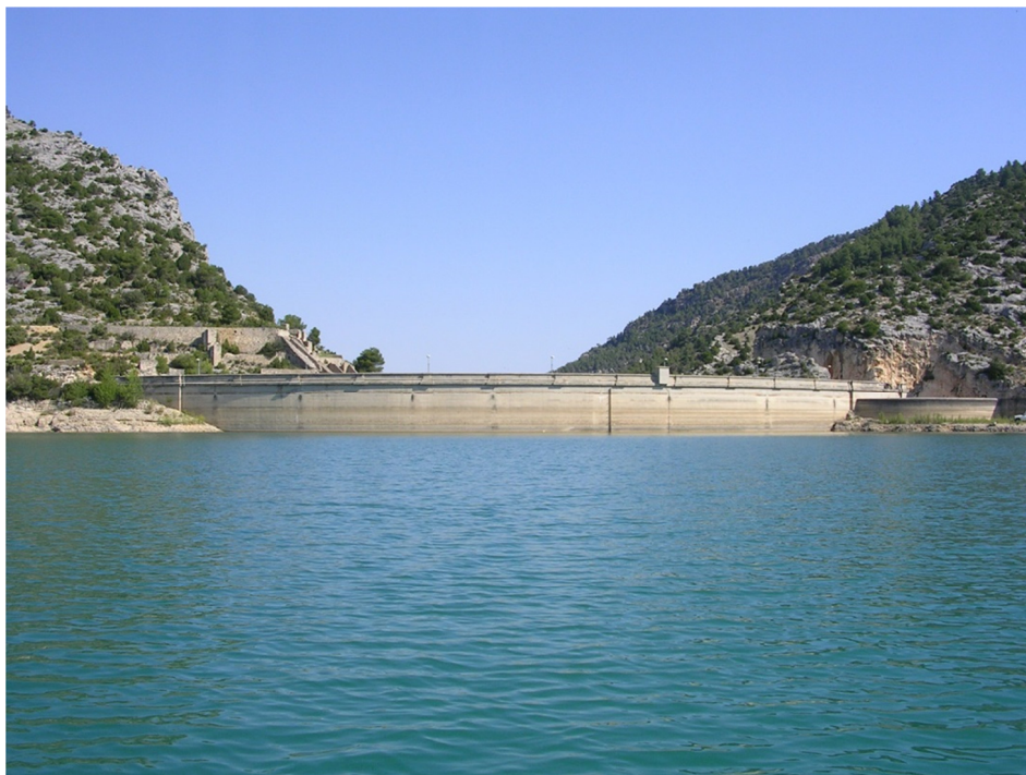
Figura 7. Vista de la presa del embalse.
