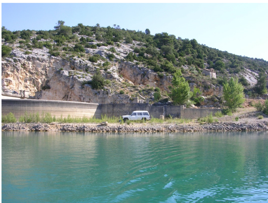
Figura 8. Vista del punto de acceso.
