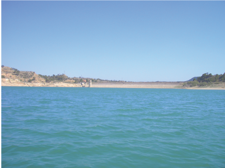
Foto 1: Vista general de la presa del embalse
