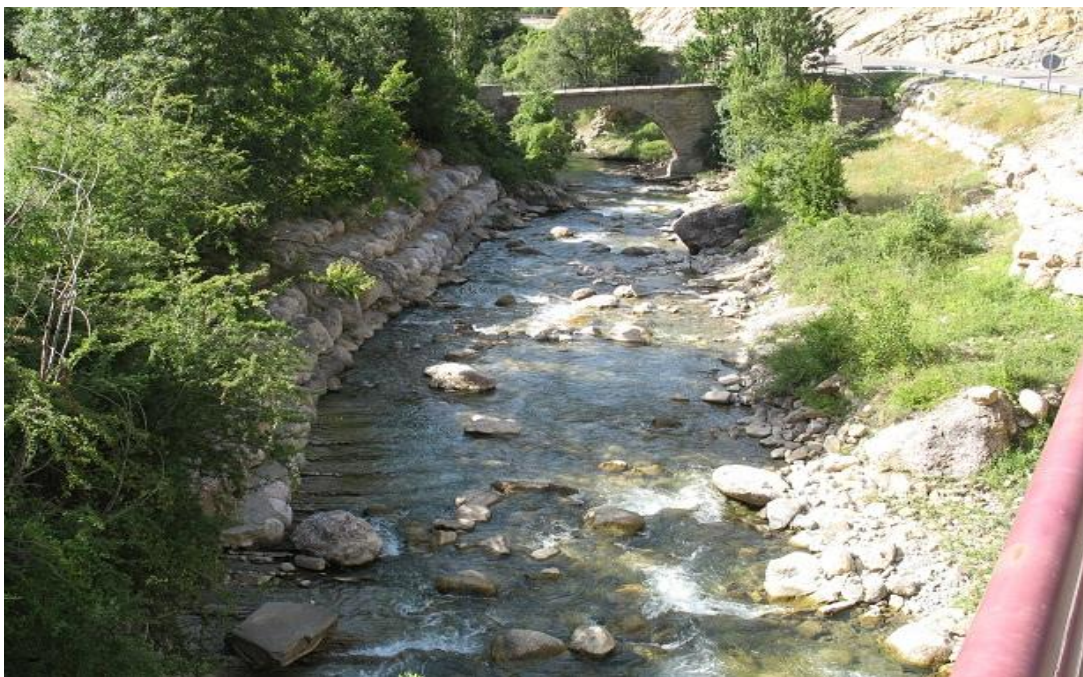
Figura 51-4. Tramo defendido del río Isábena en Las Herrerías.
