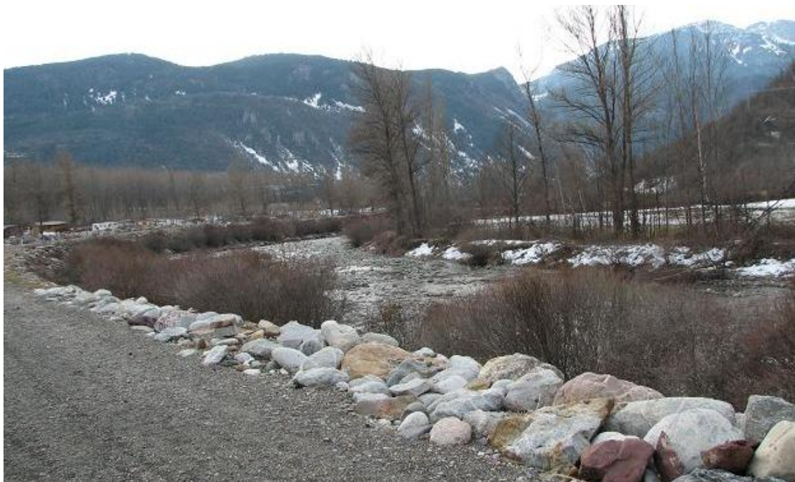
Figura 48-13. Escolleras en el entorno de Castejón de Sos.
