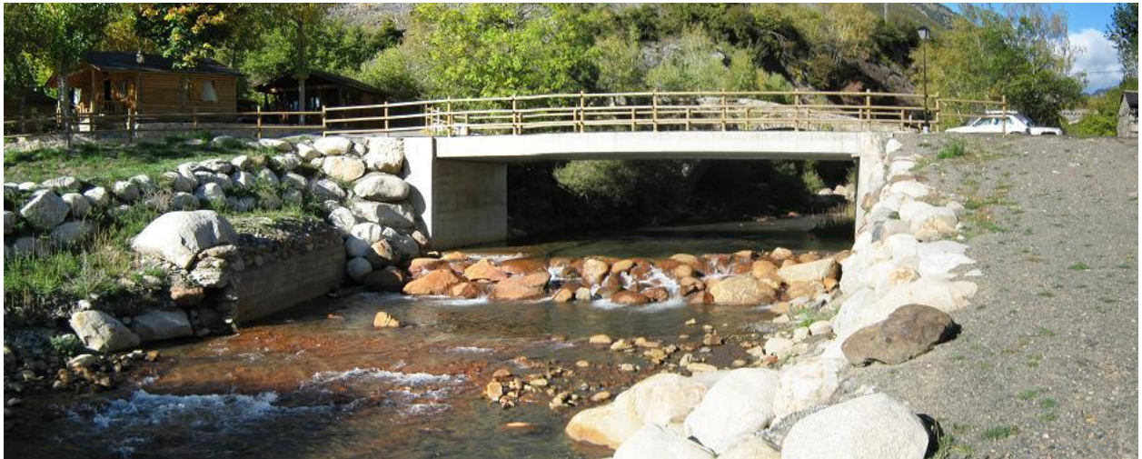
Figura 48-9. Canalización aguas arriba de la confluencia con el río Estós.
