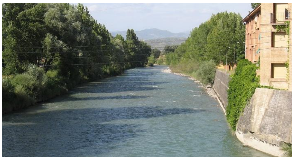
Figura 48-18. Canalización en Graus.
