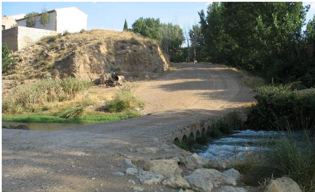
Figura 42-16. Vado aguas abajo de Oliete.
