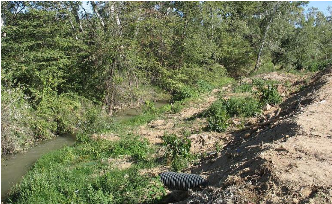
Figura 42-20. Margen y lecho alterado aguas abajo de Híjar.
