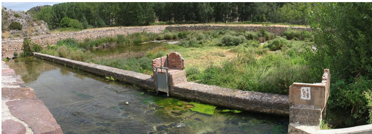
Figura 33-4. Fuente de Lagüén, aguas arriba de la localidad de Aranda de Moncayo.
