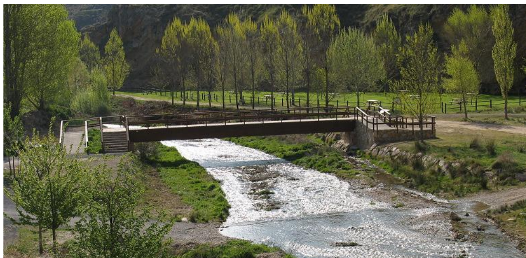
Figura 39-6. Alteración de zonas de ribera en las inmediaciones de Inestrillas
