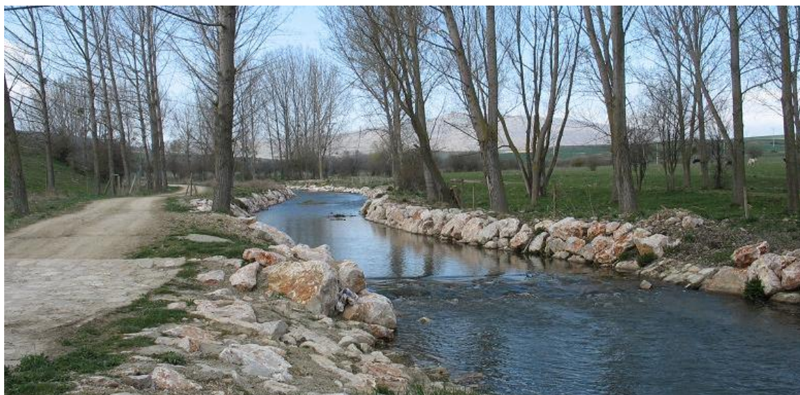
Figura 39-17. Escolleras laterales en las inmediaciones de San Pedro Manrique
