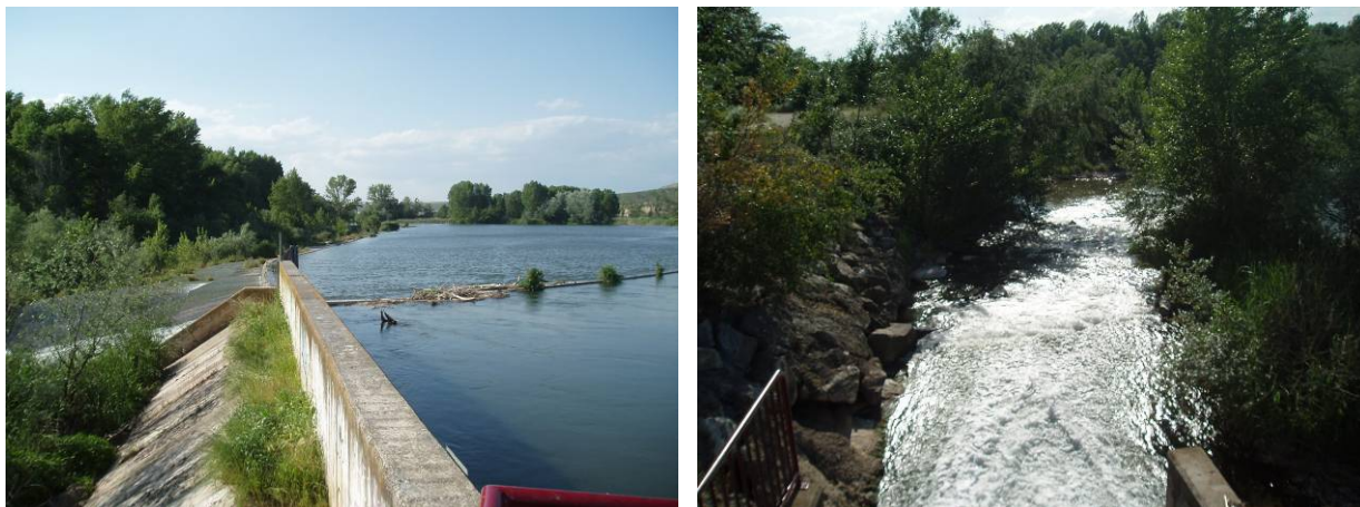
Ilustración 36: Azud del canal de la central hidroeléctrica de Sargantuda
