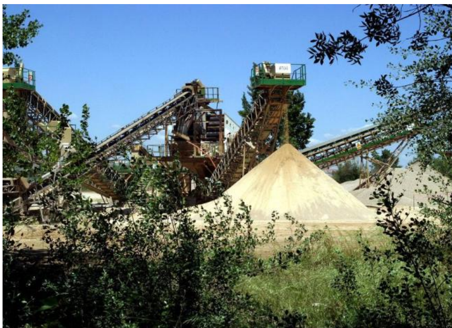
Ilustración 3: Vista general de una planta de tratamiento de áridos
