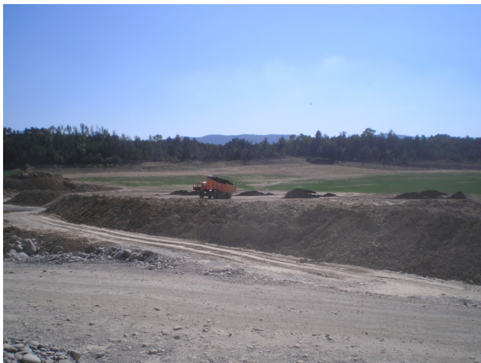
Ilustración 22: Movimiento de tierras
