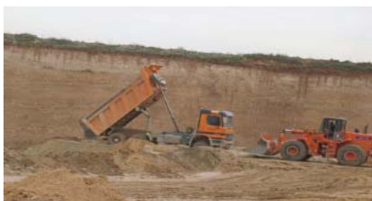
Ilustración 72: Relleno de huecos con estériles
