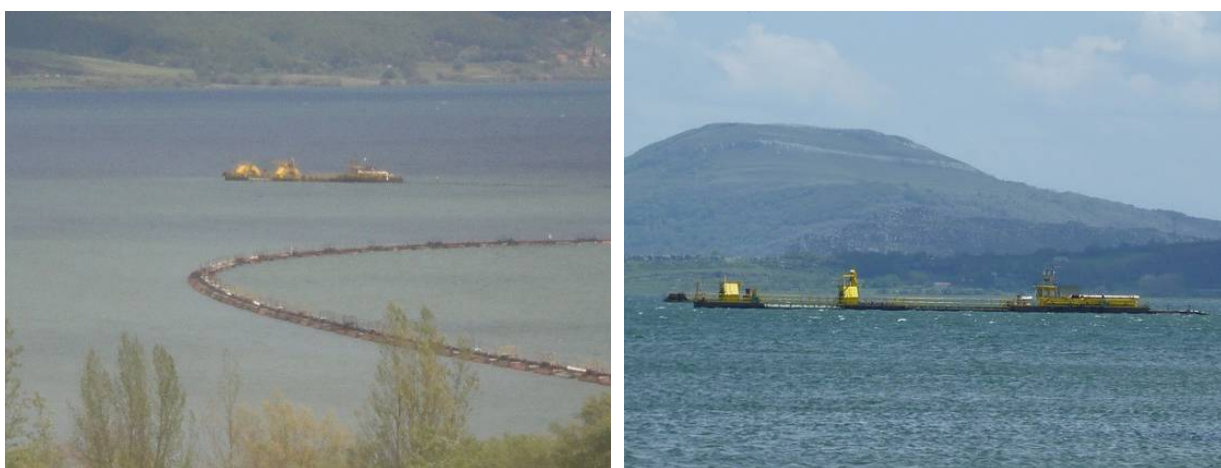
Ilustración 30: Vistas del frente de explotación
